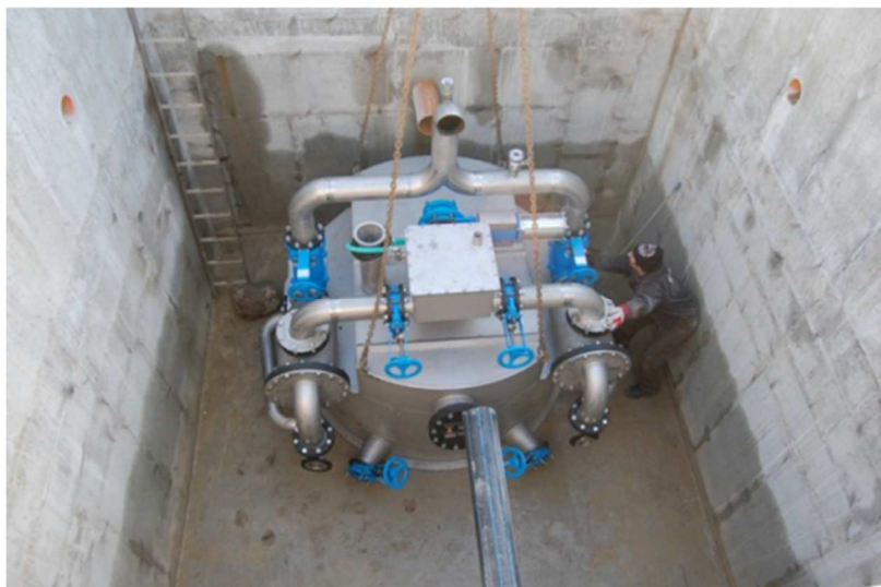
Obr. Suchá čerpací stanice – montáž
